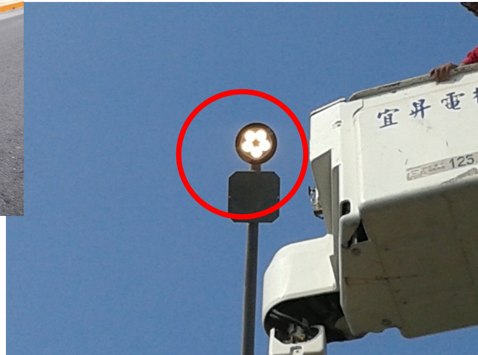
工廠外部路燈(更換後)
